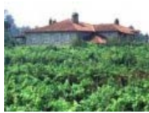
81 Casa de Covas Ponte de Lima 1 Apx4; 2 Apx2; CC
