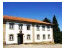
14 Casa Condado Beirós São Pedro do Sul 7 D; 3 Tw; P
