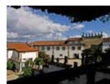
10 Casa do Campo Celorico de Basto 4 D; 5 Tw; 1 S; P; T
