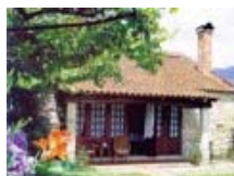
86 Casa da Gaiba Ponte de Lima 1 Apx4; CC
