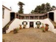
09 Casa das Calhetas S. Miguel – Açores 2 D; 1S
