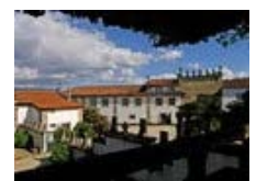
10 Casa do Campo Celorico de Basto 4 D; 5 Tw; 1 S; P; T
